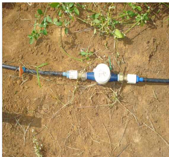
Figura 3 - Registro na entrada de cada linha lateral de cada experimento.
