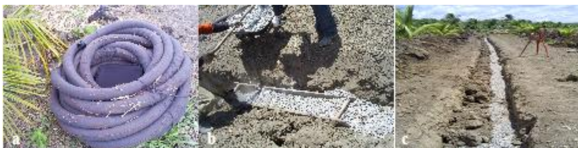
Figura 3 - Tubo drenoflex envolto com manta bidim OP – 20 (a), caixa de brita revestindo o dreno (b) e dreno instalado (c).
