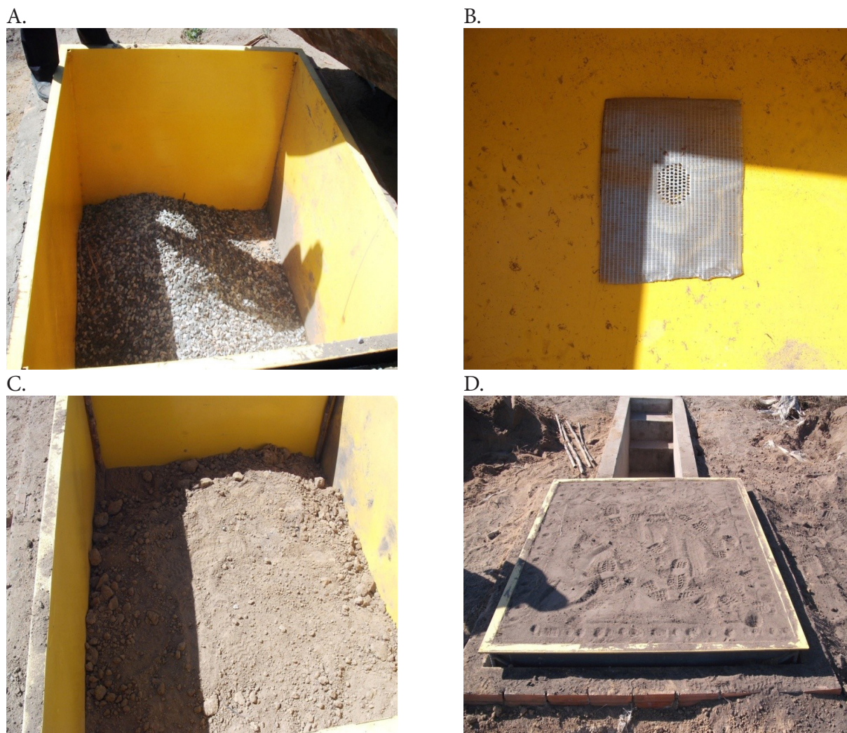
Figura 5. Camada de brita (A), manta de poliéster (B), acomodação (C) e preenchimento do solo na caixa lisimétrica (D).
