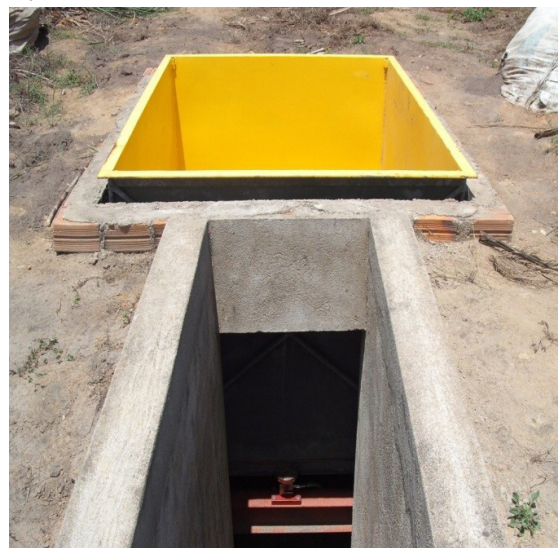
Figura 4. Momento da instalação da caixa lisimétrica em campo (A, B).
